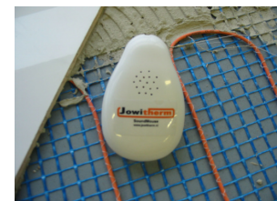
SoundMouse: Uniek testapparaat tijdens het aanleggen van de vloerafwerking.
